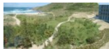
竣工時の状況
